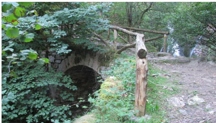
Puente de La Pontona
