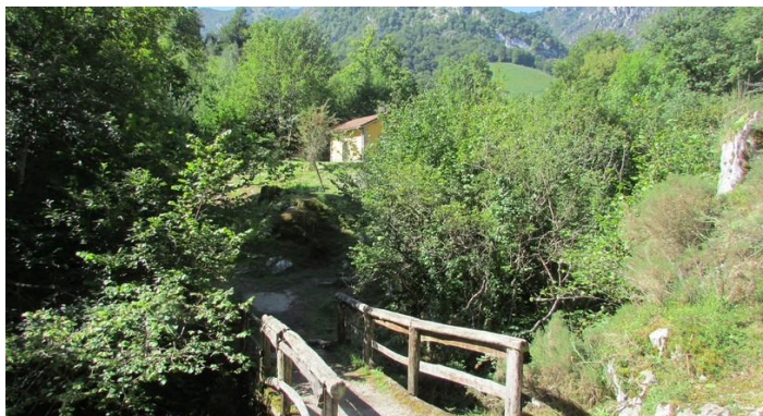
Puente y llegada al Cruce de Ríos
