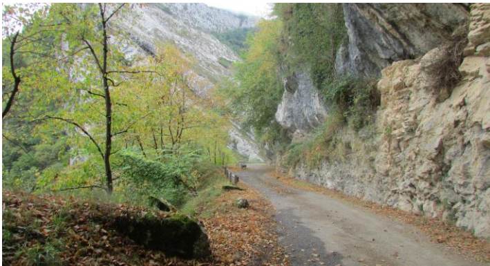
Tramo de carretera cerca de Sobrefoz
