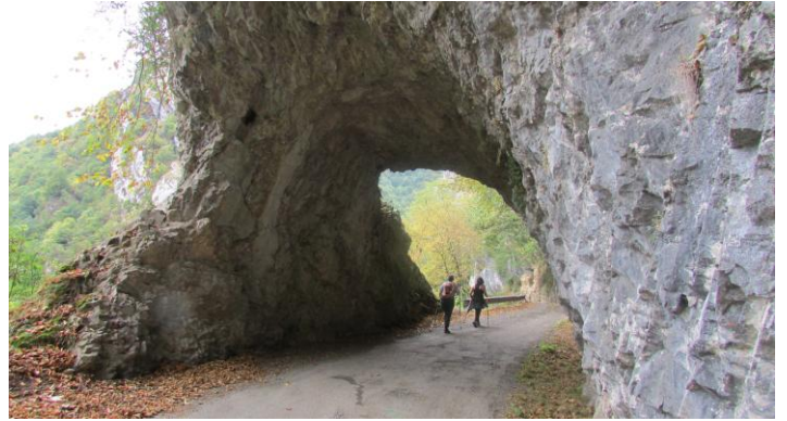
Uno de los túneles de la PO-3 antes de Sobrefoz
