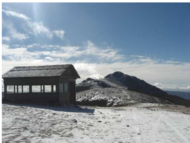
Refugio de Servicio forestal antincendios
