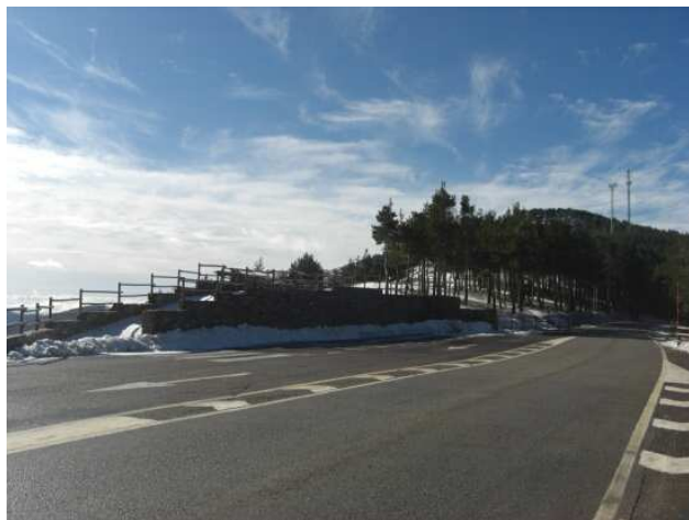
Inicio de la ruta en el Puerto de La Puebla
