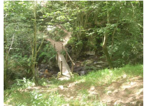
Puente del Pendón
