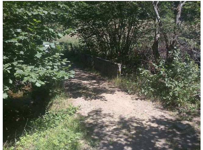
Puente sobre el Río Nalón
